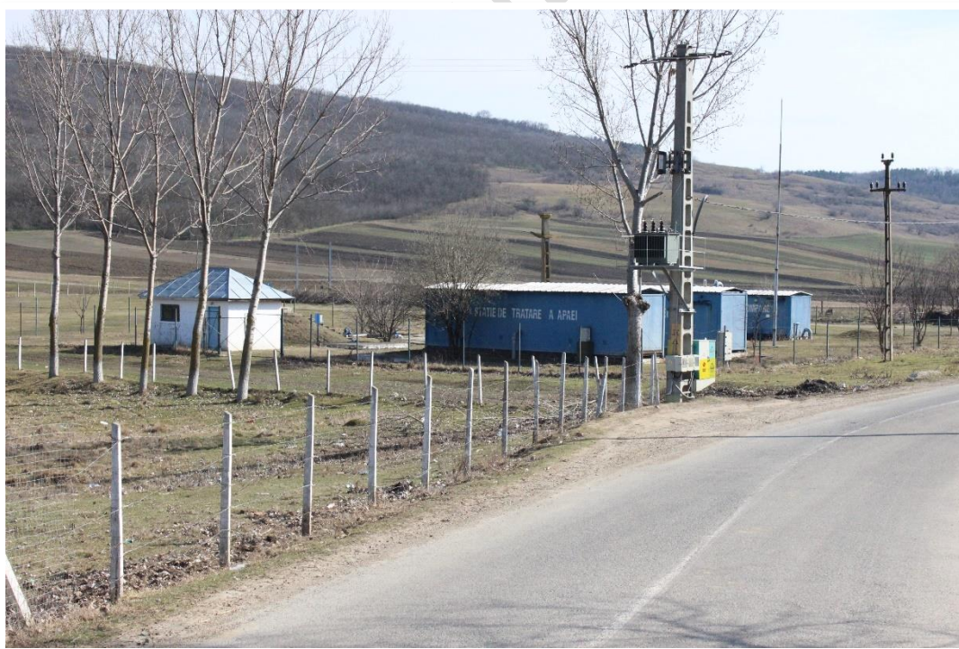
Stație de tratare a apei - comuna Vutcani
